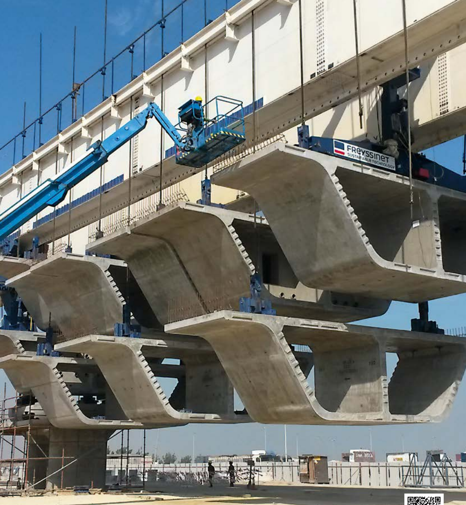
Puente de carretera de Damman, Arabia Saudí.
