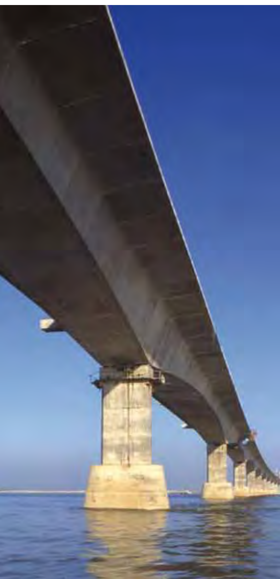
Puente de Jamuna, Bangladesh
