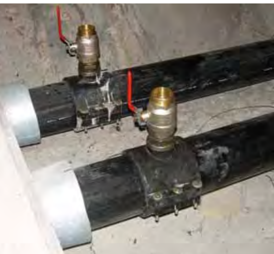
Toma de inyección sobre conducto en PEAD
