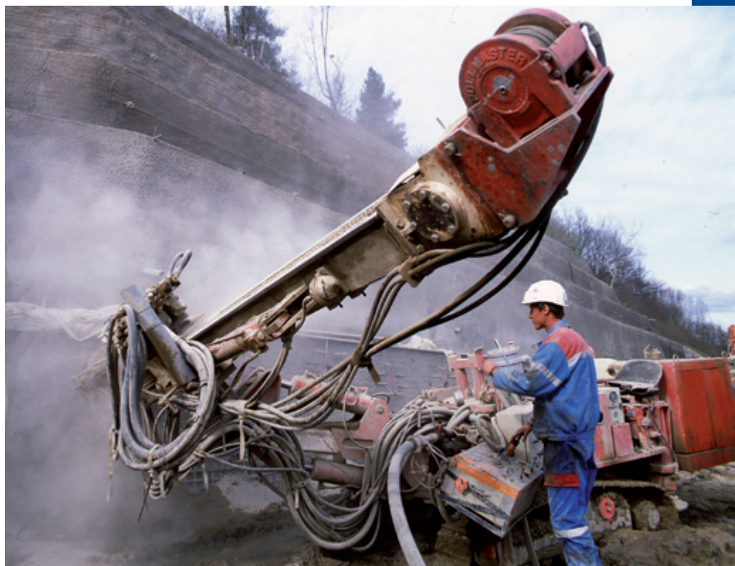
Anclajes al Terreno
