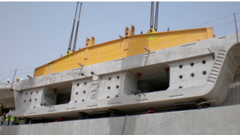
Izado: conexión pretensada entre un segmento y una viga.
