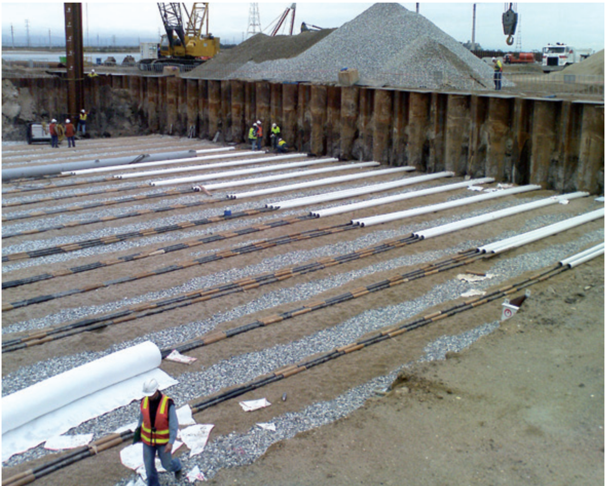
Tirantes permanentes para muros de muelle
