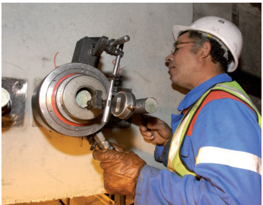
Tensado mediante gato articulado
