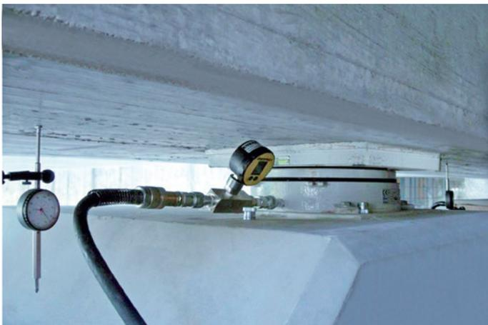
Este sistema permite elevar la superestructura actuando directamente sobre el apoyo. En el caso de los cilindros de suspensión, lo que se hace es inyectar un fluido (pasta, resina, etc.) en el cilindro, debajo del disco de elastómero. Con los apoyos de elastómero, se coloca un gato plano Freyssinet bajo el bloque de elastómero.
