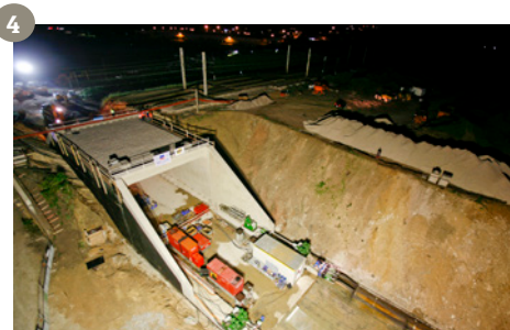
4 - Deslizamiento final y terraplenado
