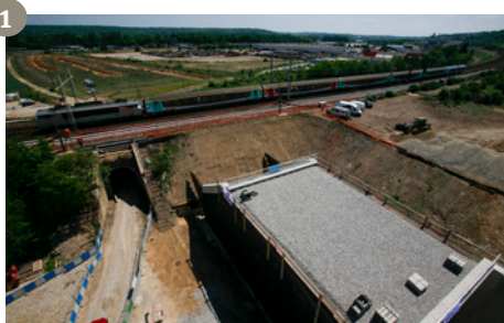
1 - Prefabricación de la estructura cercana a la vía y montaje de la nariz para el proceso de hincar
