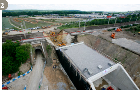
1 - Prefabricación de la estructura cercana a la vía y montaje de la nariz para el proceso de hincar
