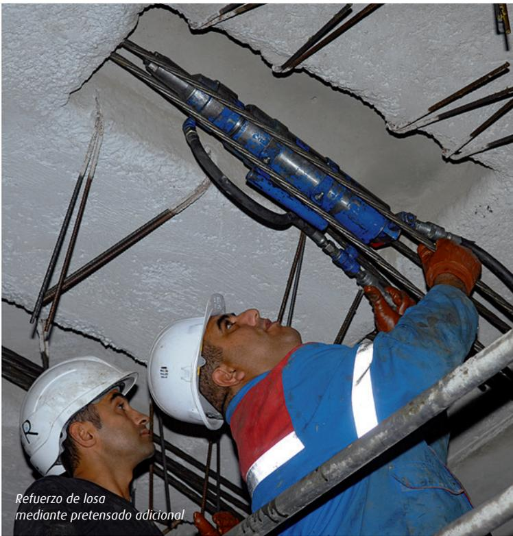
Refuerzo de losa mediante pretensado adicional
