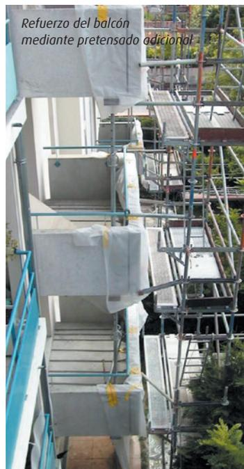
Refuerzo del balcón mediante pretensado adicional
