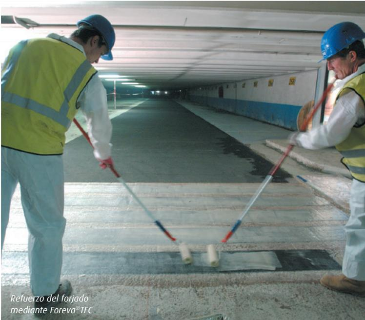
Refuerzo del forjado mediante Foreva® TFC
