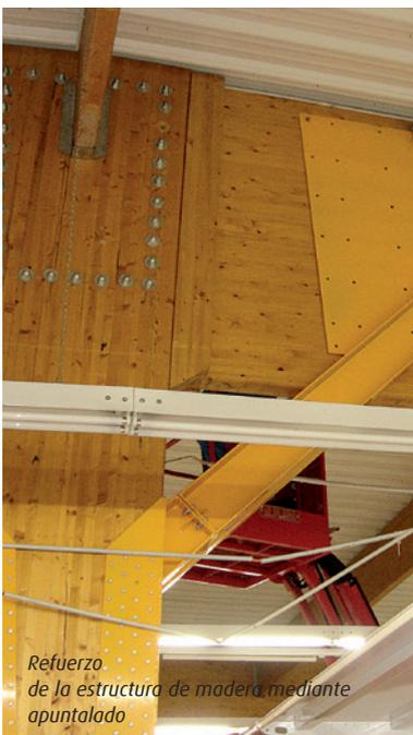
Refuerzo de la estructura de madera mediante apuntalado
