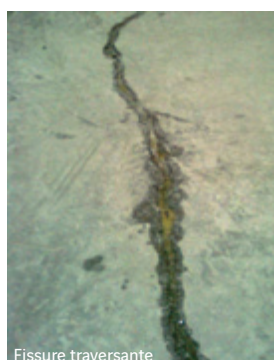
Fissure traversante
