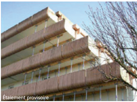
Étalement provisoire
