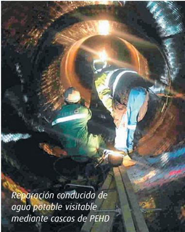
Reparación conducida de agua potable visitable mediante cascos de PEHD
