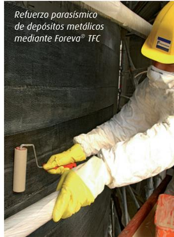
Refuerzo parasísmico de depósitos metálicos mediante Foreva® TFC
