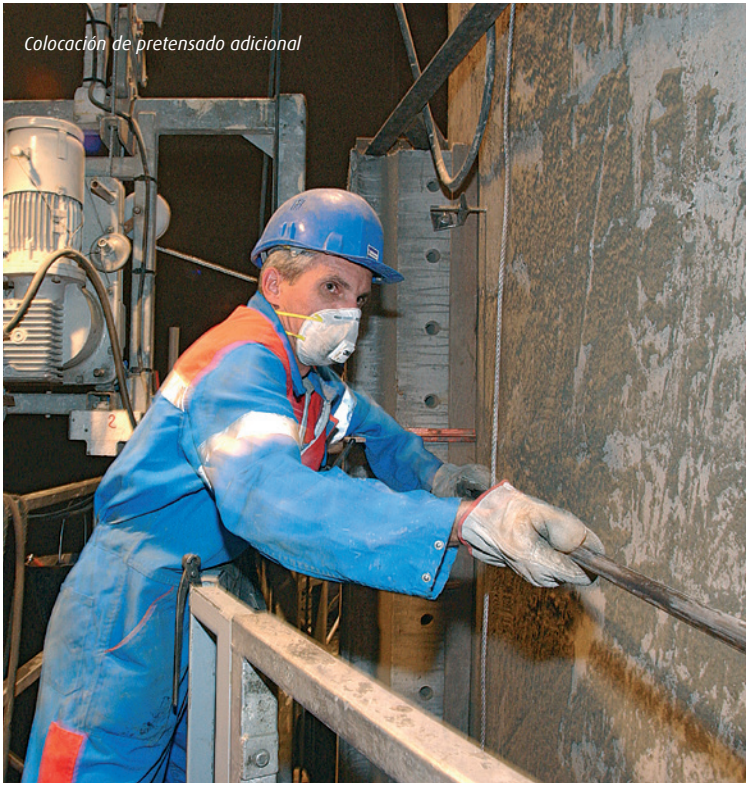
Reparación de postes con hormigón proyectado
