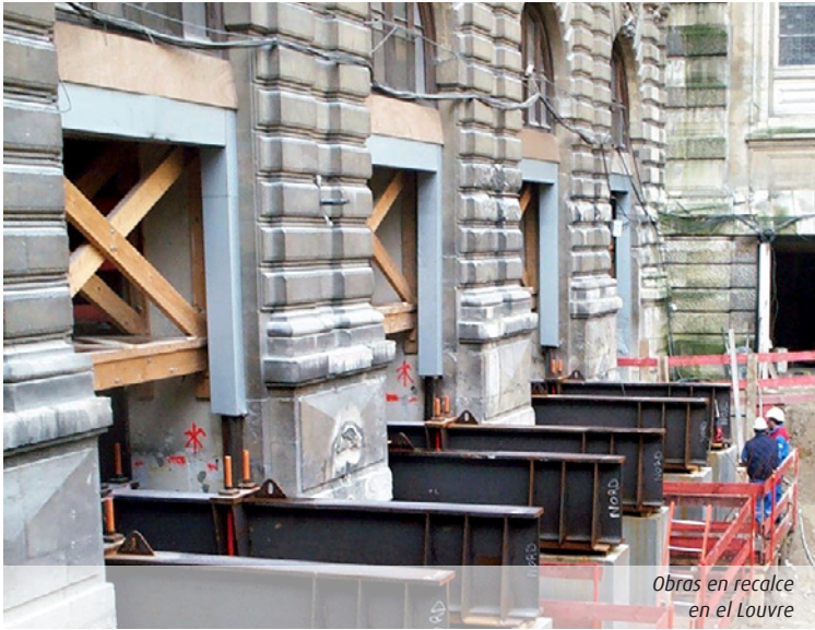
Vigas de cintura mediante juncos compuestos
