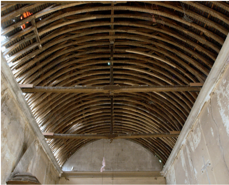
Alteración de la madera estructural
