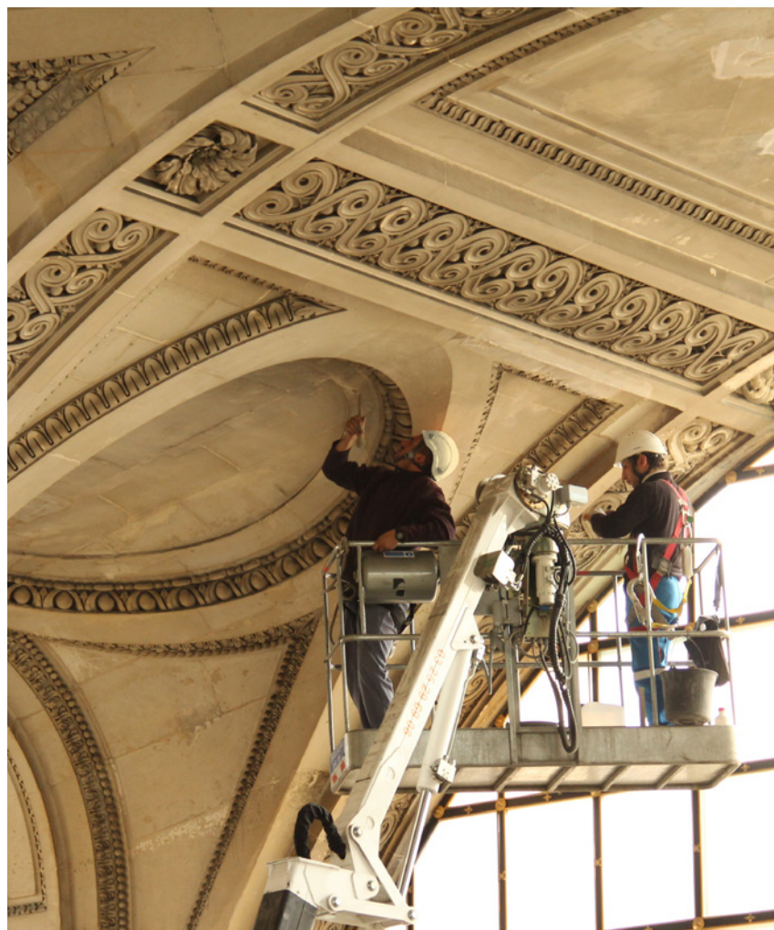
Reparación local del techo, Panteón (Francia)
