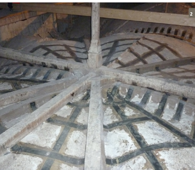
1 - Vista del intradós de la cúpula, Iglesia de san Florentino de Amboise, Francia
