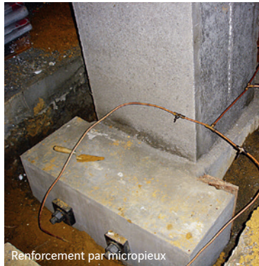
Renforcement par micropieux
