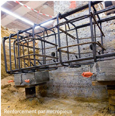
Renforcement par micropieux
