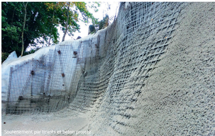
Soutènement par tirants et béton projeté
