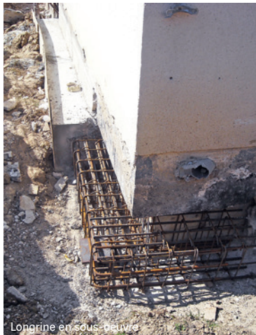
Longrine en sous-œuvre
